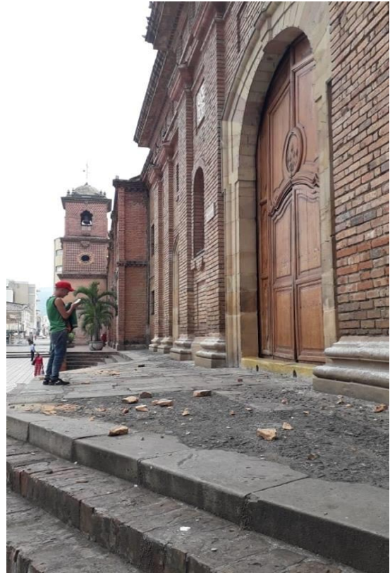
Figura 8. Daños en la fachada edificio Calle 9 con 42 y en la Iglesia San Francisco.
